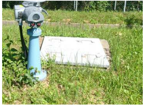
환기구 등의 덮개(장비 반입구) 현황
