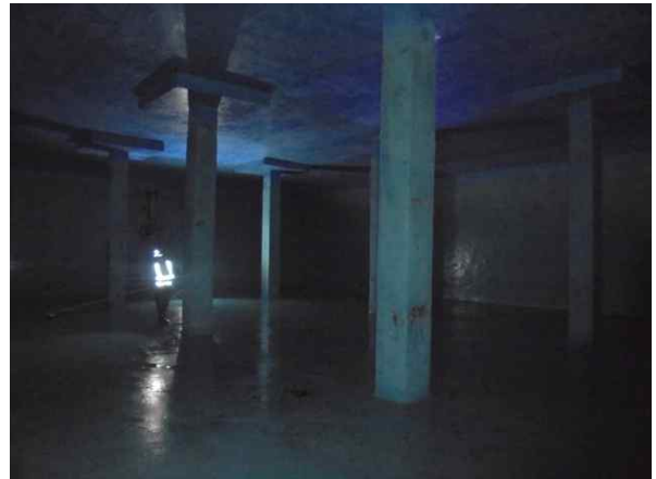
배수지 2지 내부 전경
